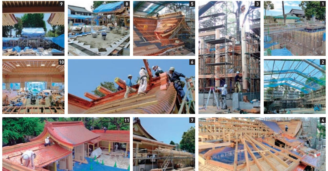
1 御本殿基礎工事 2 素屋根工事 3 御本殿建方 4 御本殿屋根工事 5 御本殿銅板葺工事 6 千木鯉木取付 7 右廻廊屋根工事 8 内庭石畳工事
